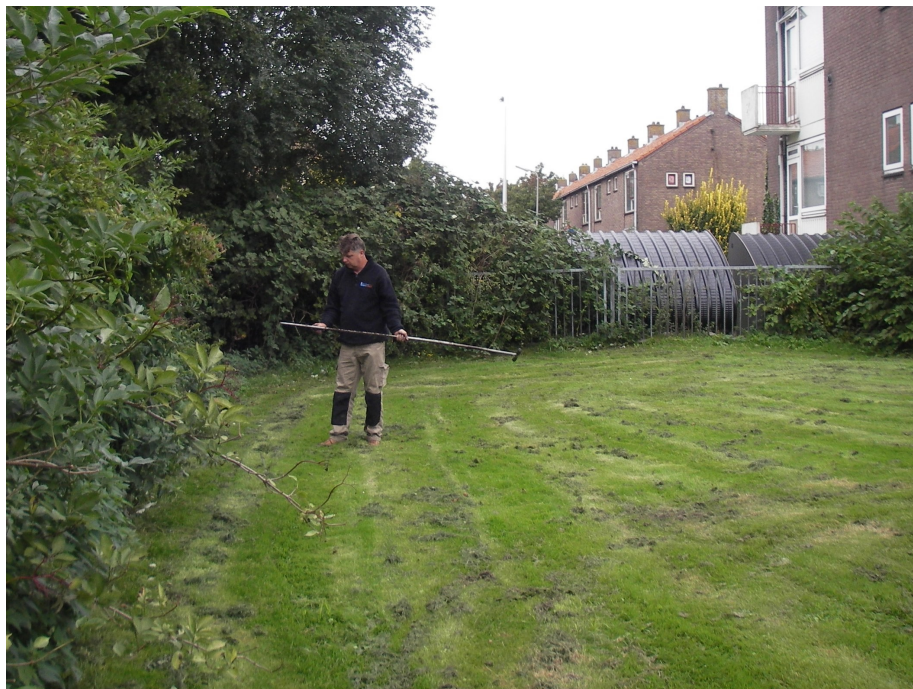
Figuur 5. Schoonhoven, Mr. Kesperstraat. Het zetten van boring 4 (gezien vanuit het oosten)
