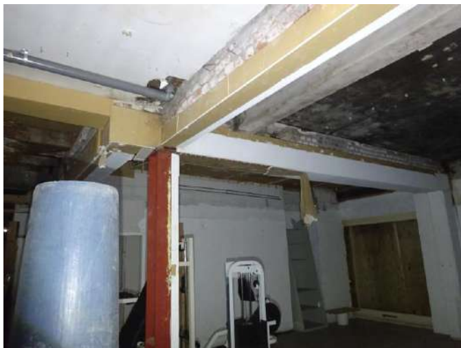
Brandwerende bekleding niet asbestverdacht
