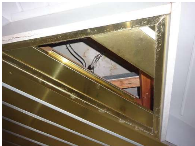
Inspectie achter wand, plafond en onder vloerafwerkingen
