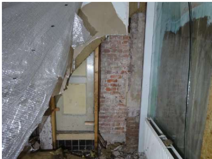
Inspectie achter wand, plafond en onder vloerafwerkingen
