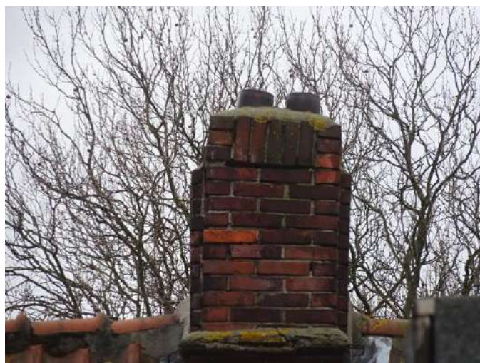
Gres buis op de schoorstenen
