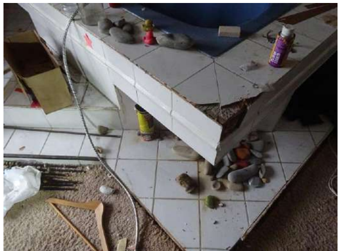
Inspectie onder tegelwerk
