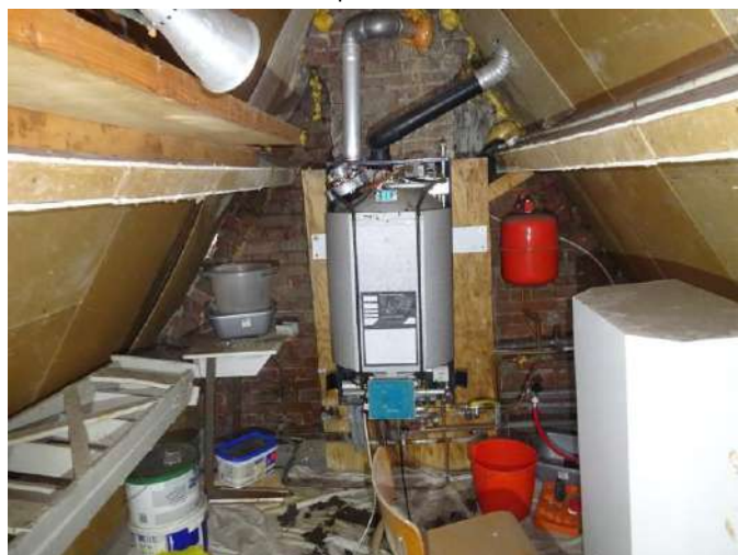
Installaties niet asbestverdacht
