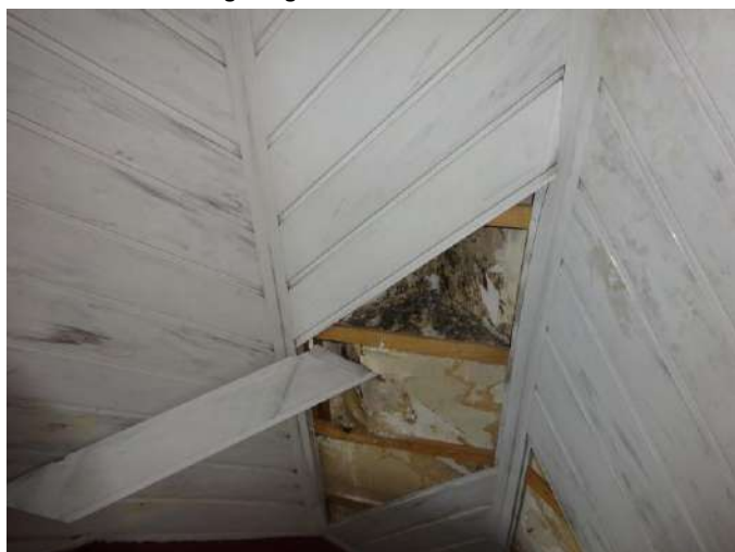
Inspectie achter wand, plafond en onder vloerafwerkingen
