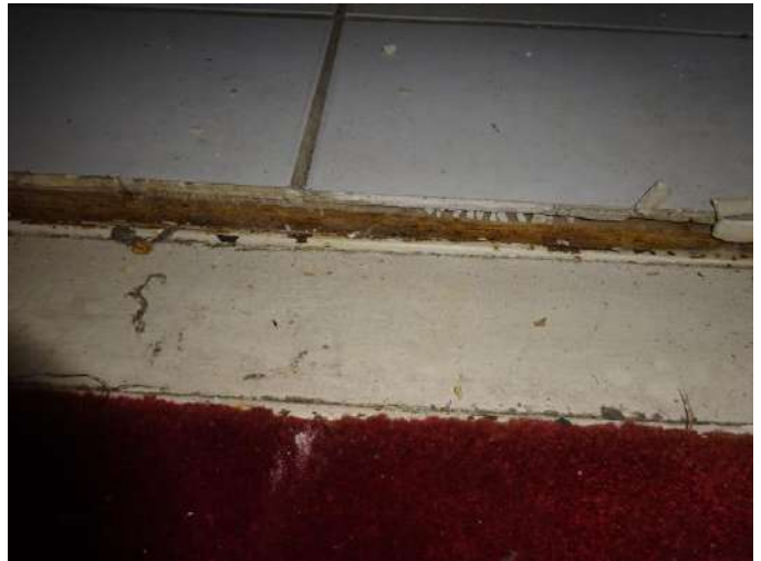
Inspectie onder tegelwerk
