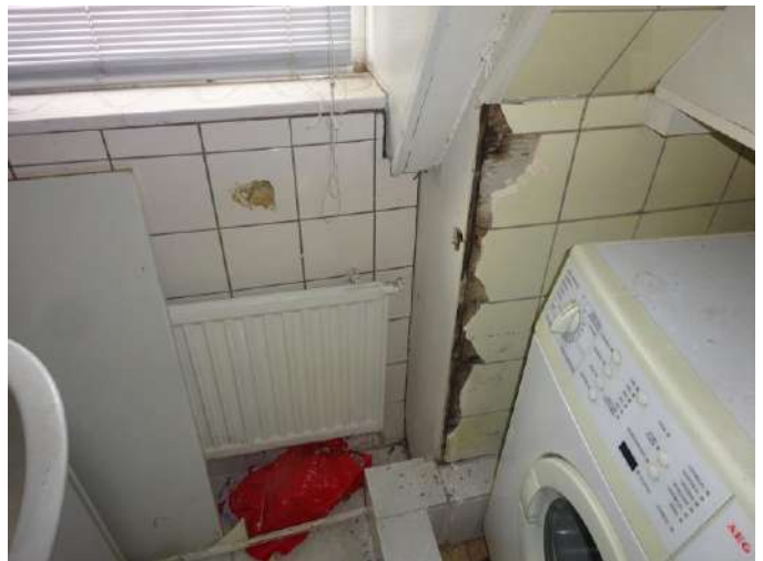
Inspectie onder tegelwerk
