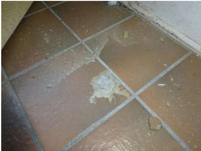
Inspectie onder tegelwerk
