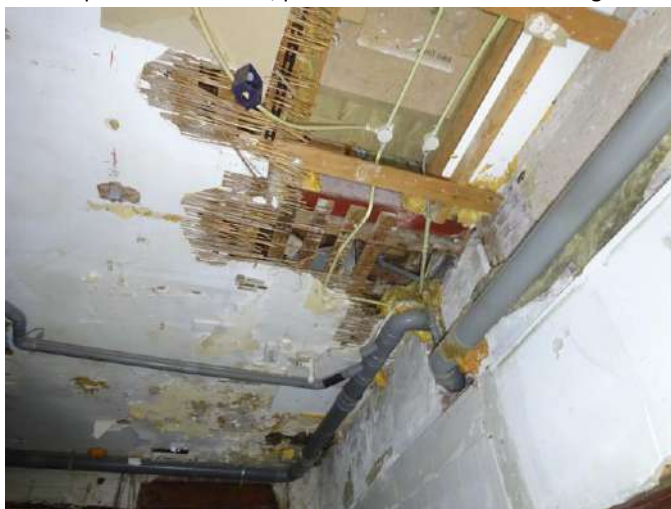
Inspectie achter wand, plafond en onder vloerafwerkingen
