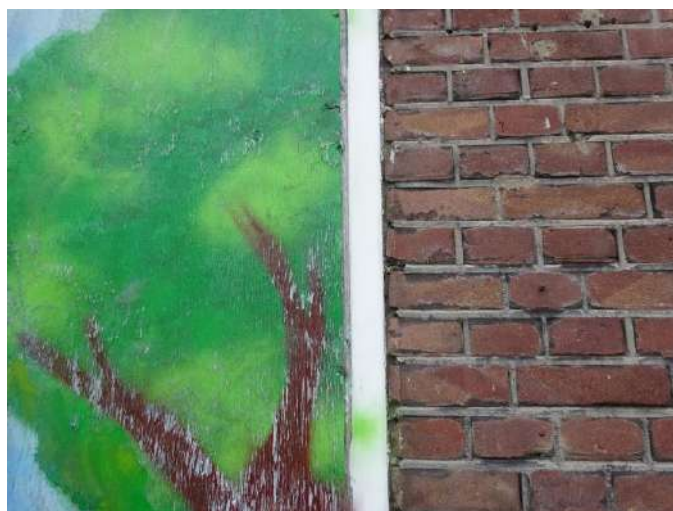
Kit naast kozijnen niet asbestverdacht
