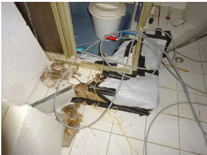
Inspectie onder tegelwerk
