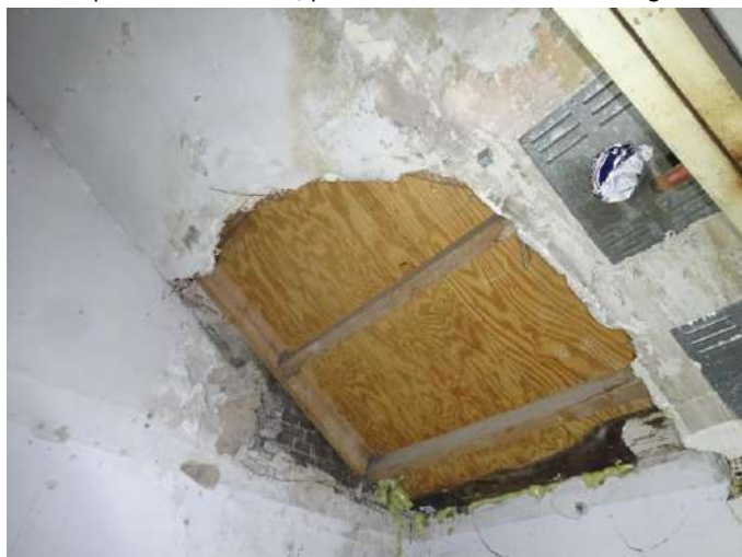
Inspectie achter wand, plafond en onder vloerafwerkingen
