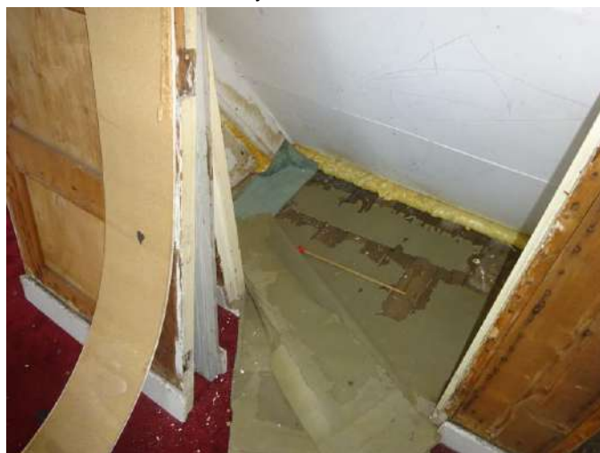
Inspectie achter wand, plafond en onder vloerafwerkingen
