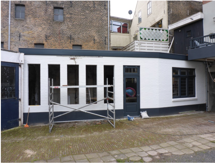
Afb. 9. De aanbouw tussen de woonhuizen aan de Tuinlaan en de achterbebouwing
