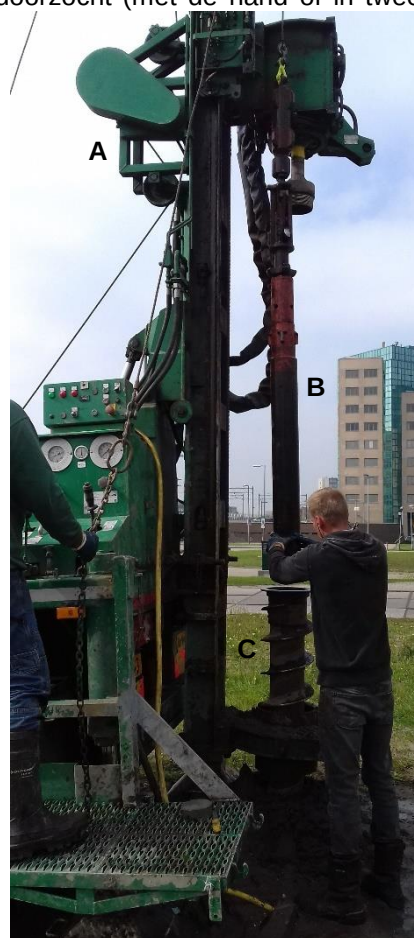
Figuur 4: boring met een Holle Avegaar. A. boorinstallatie. B. boorstang. C. avegaar.
