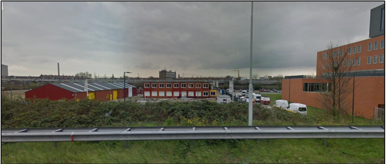
Figuur 29. De rode loods met zwart pultdak (links op de foto) en het gebouw van Zuid Holland Infra met hiervoor een gasverdeelstation (midden op de foto) zijn tijdens, danwel na het vooronderzoek gerealiseerd. Gezien de typen bouwwerken, zijn hiervoor geen diepere grondroerende werkzaamheden uitgevoerd (Bron: Google Maps, d.d. maart 2019).
