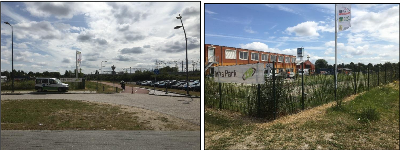
Figuur 34. Fietspad, parkeerplaats met bestrating, openbare verlichting en hekwerken aan zuidzijde verdacht gebied A0077.
