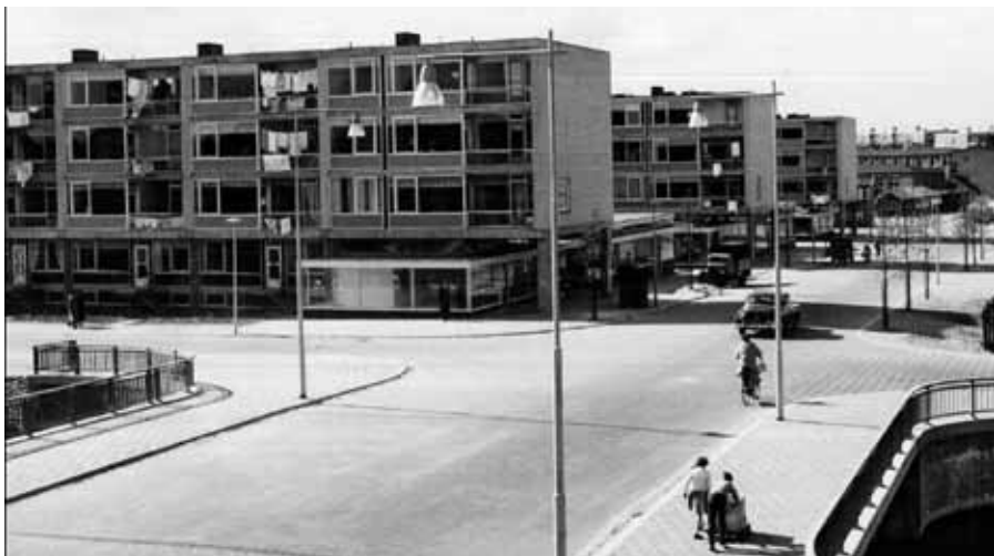
Zicht vanuit het centrum over de Parkweg
