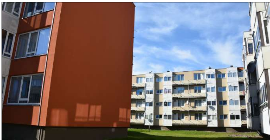
Figuur: ten zuiden van het plangebied zijn enkele appartementencomplexen aanwezig welke ongeschikt zijn voor vleermuizen. Er zijn geen geschikte invliegopeningen aangetroffen.
