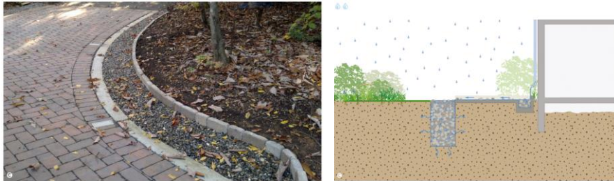
Figuur 5-3 Principe van grindstroken
