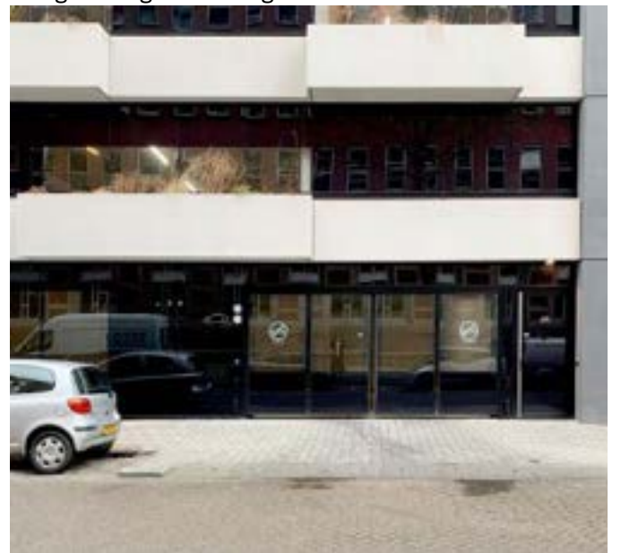
Technische ruimtes en installaties zijn meeontworpen
