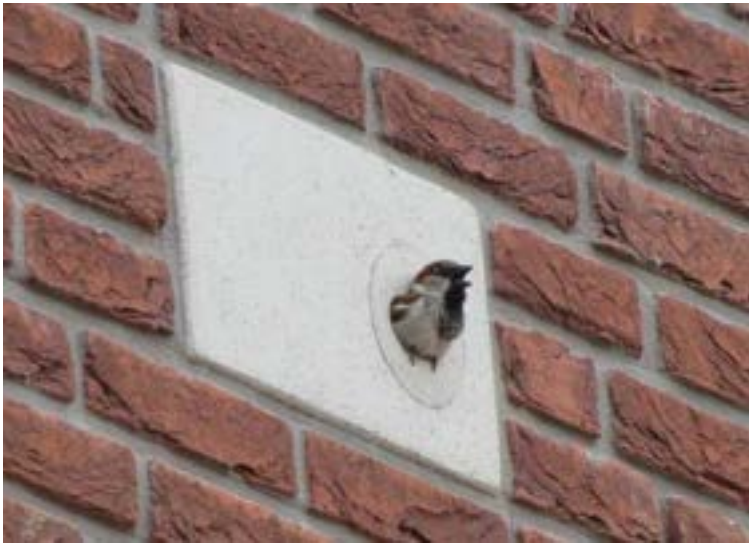
Nestkasten in de gevel
