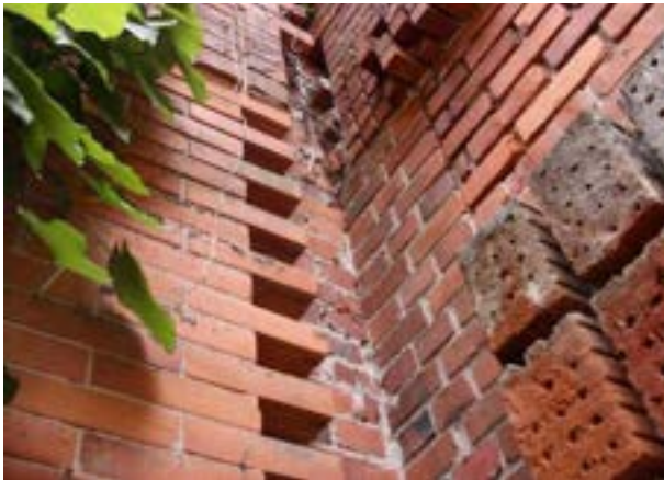
Openingen in metselwerk
