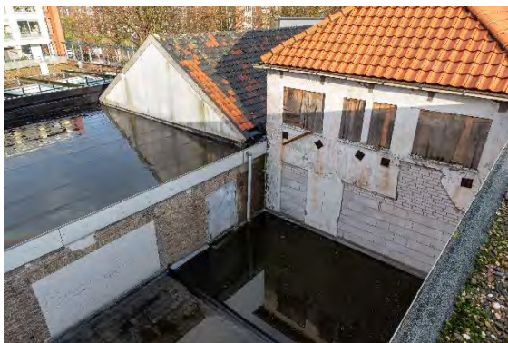
Overzicht achterzijde panden 03 en 02
