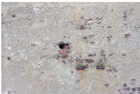
Gaten in de pand die toegang bieden tot spouw
