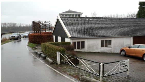
Foto 1: Polderweg 260 (te slopen schuur)
