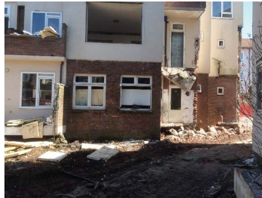
foto 2: opname gedeelte Blok B
