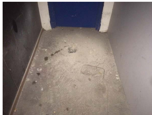
foto 4: opname gedeelte Blok C (in pandig)
