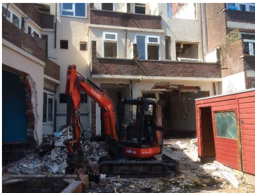
foto 3: opname gedeelte Blok B
