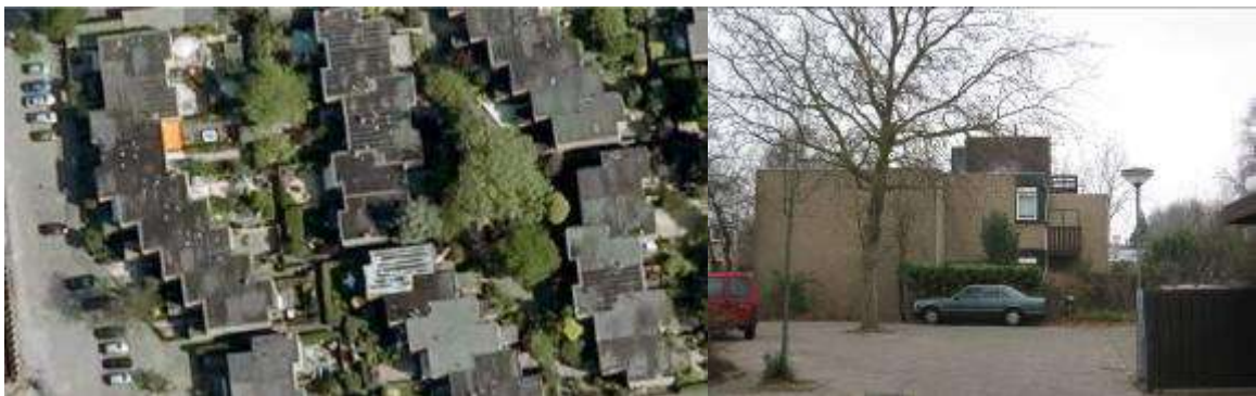
Afbeelding 6: Trapsgewijze opstelling & Dakopbouw
