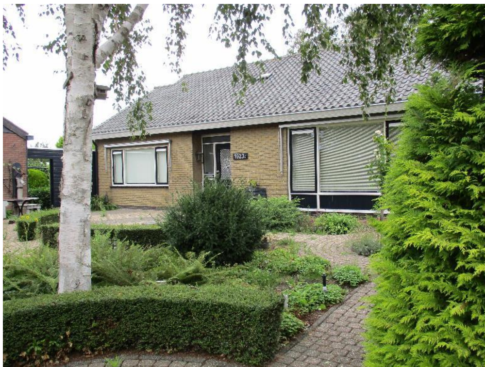
Figuur 3 Op de planlocatie is tevens een woning met een siertuin aanwezig die niet gesloopt zal worden.
