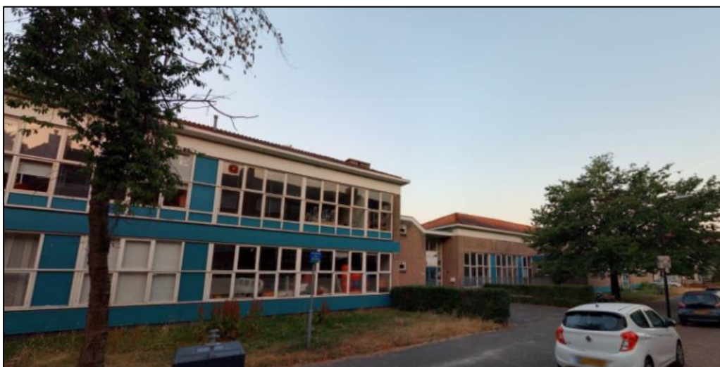
Foto van de huidige bebouwing aan de Generaal Vetterstraat 38 te Rijswijk. De bebouwing was tot voor kort in gebruik als schoolgebouw. Bron: streetsmart, 2019.
