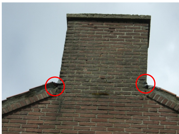
Foto 1: Opening in nok kopgevel
