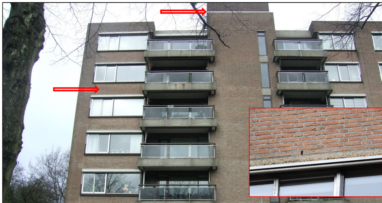
Afbeelding 2: Open stootvoegen en daklijsten Doctor H. Colijnlaan aangegeven met rode pijl
