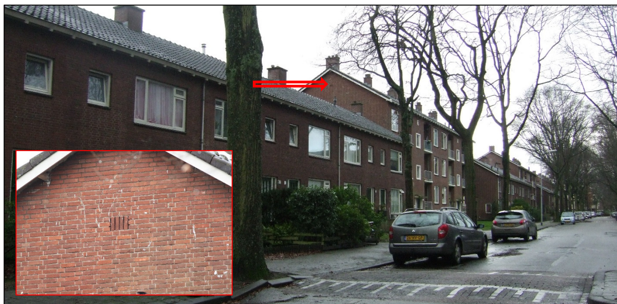
Afbeelding 3: Open luchtroosters Karel Doormanlaan aangegeven met rode pijl
