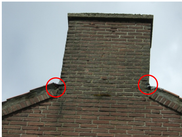
Foto 1: Opening in nok kopgevel
