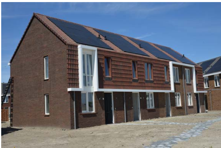
Foto eerste woningen Sion RijswijkBuiten met zonnepanelen
