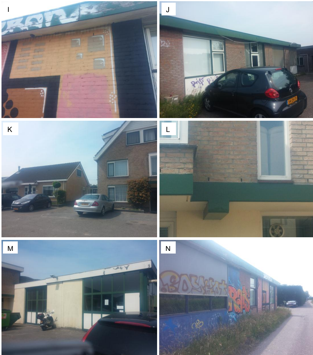
Foto's I t/m N: Gebouwen in het oostelijk deel van het plangebied die, vanwege de aanwezigheid van spouwgaten (I, K, L) en/of andere openingen die als mogelijke invliegopening kunnen dienen, potentieel geschikt zijn als vleermuisverblijfplaats (door Sanne Westbroek).
