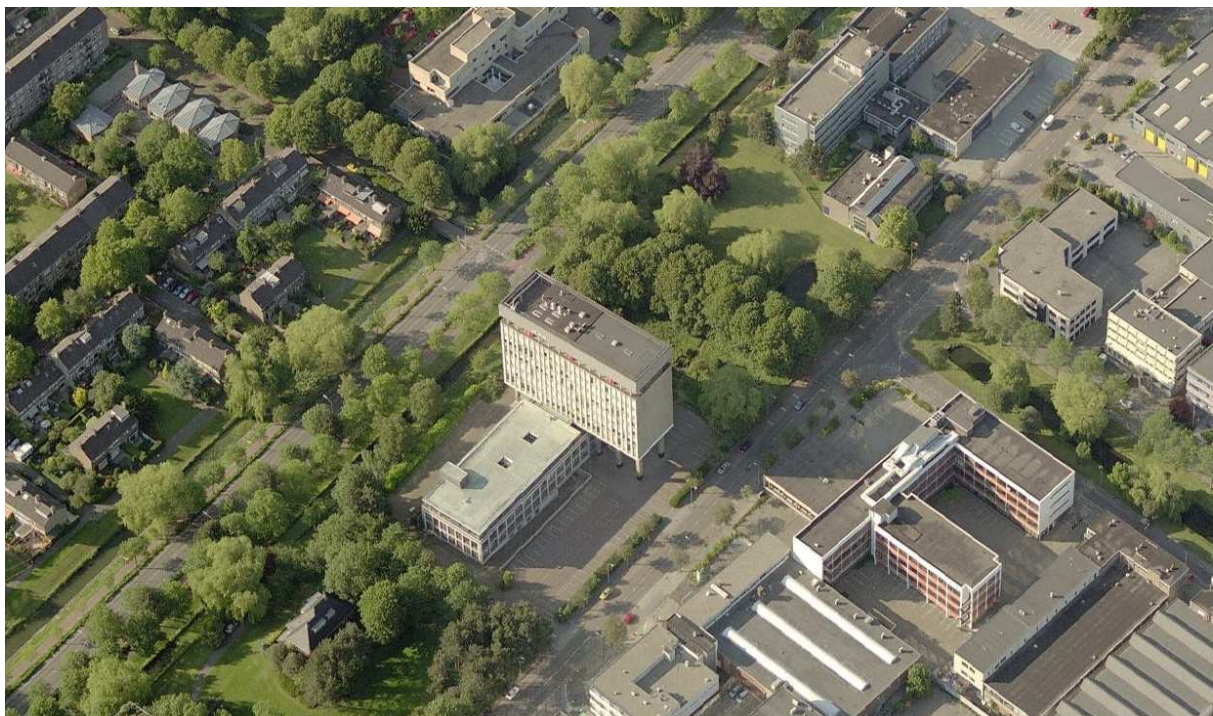
Luchtfoto gesloopte kantoor
