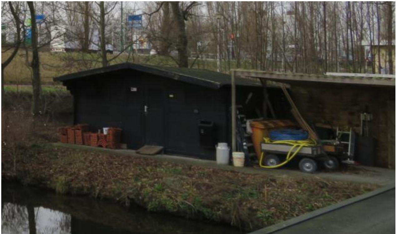
De voor vleermuizen ongeschikte schuur die wordt gesloopt in het plangebied.
