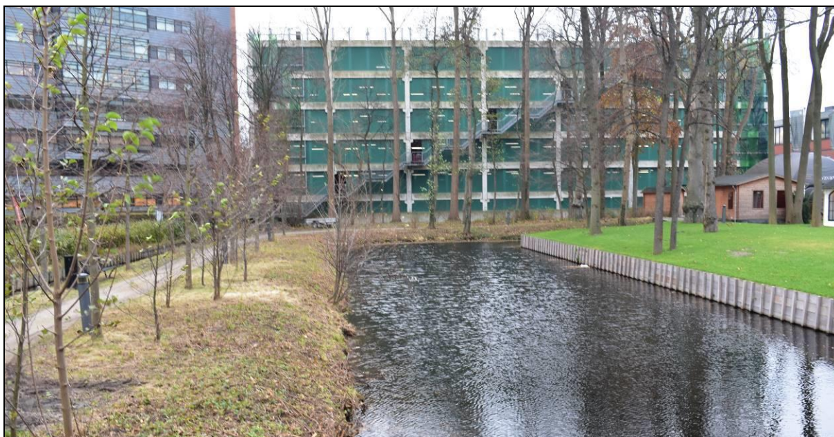
De parkeergarage aan de Laan van Zuid Hoorn 38.
