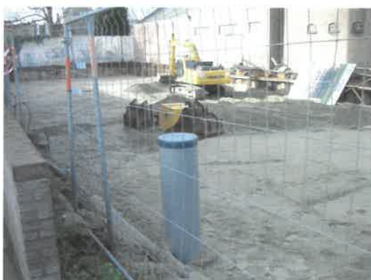
Foto 12: Pompput drainagesysteem
