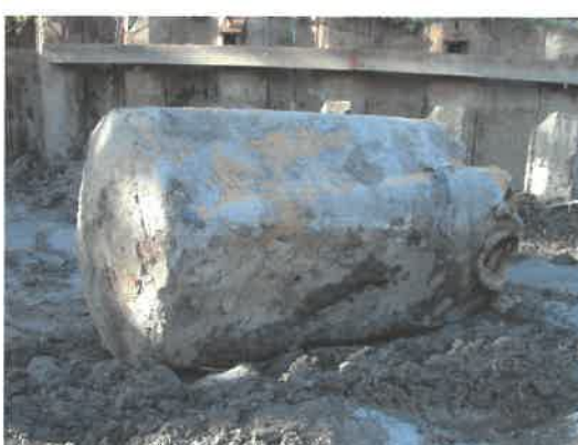
Foto 6: Halve ondergrondse tank
