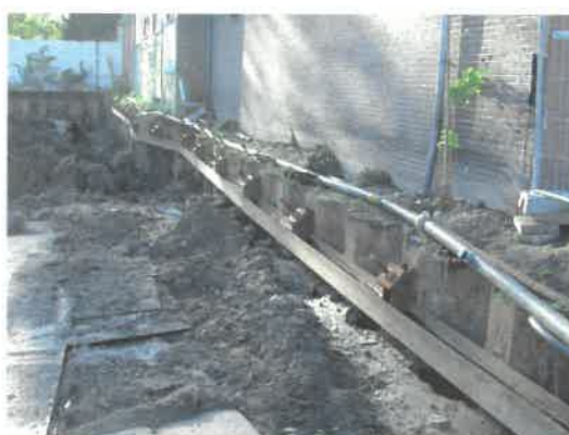
Foto 2: Damwand met groutankers
