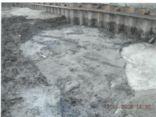
Foto 5: Aanvang ontgraving fase 2
