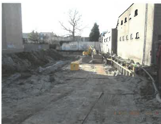
Foto 4: Aanvang ontgraving fase 2
