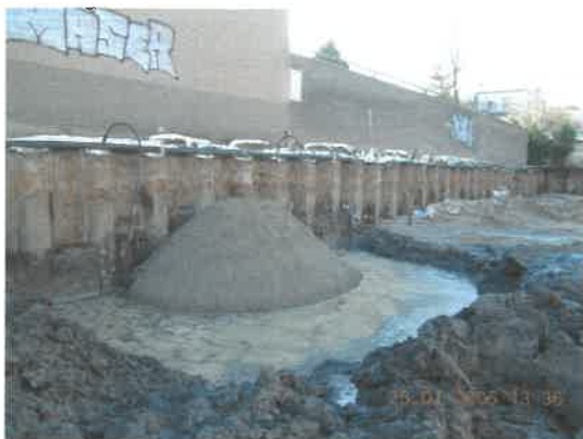
Foto 9: Ballast tegen damwand
