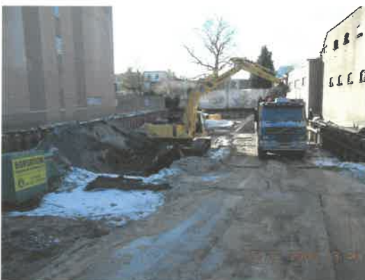
Foto 8: Laden en afvoeren grond
