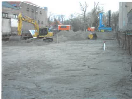
Foto 10: Aanvullen put met schoon zand
