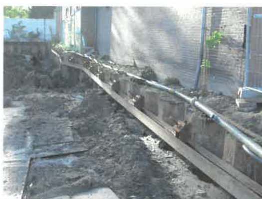
Foto 2: Damwand met groutankers
