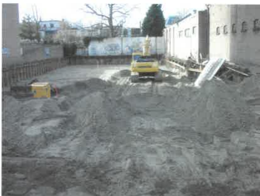
Foto 11: Aanvullen put met schoon zand
