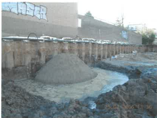
Foto 9: Ballast tegen damwand
