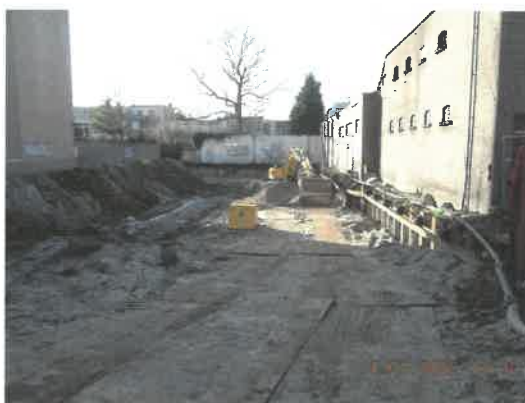
Foto 4: Aanvang ontgraving fase 2
