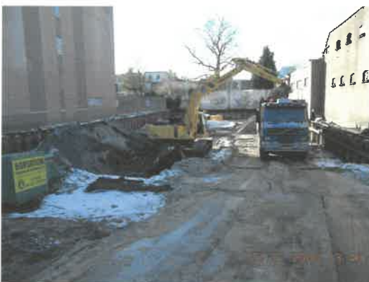
Foto 8: Laden en afvoeren grond
