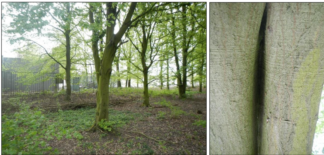
Figuur 4. Enkele van de onderzochte bomen en een voorbeeld van een geïnspecteerde boomspleet.
