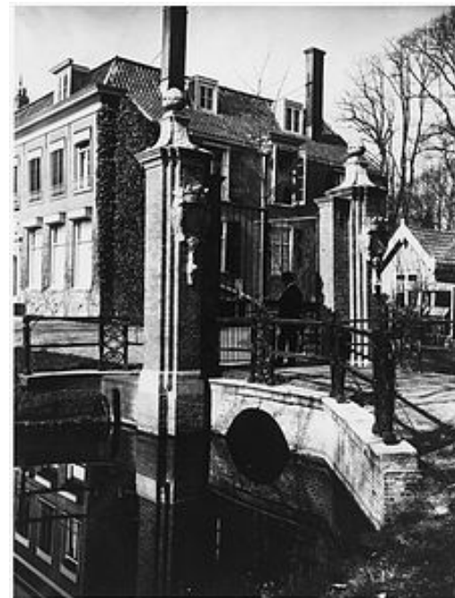
Toegangshek Huis Overvoorde (1960)
