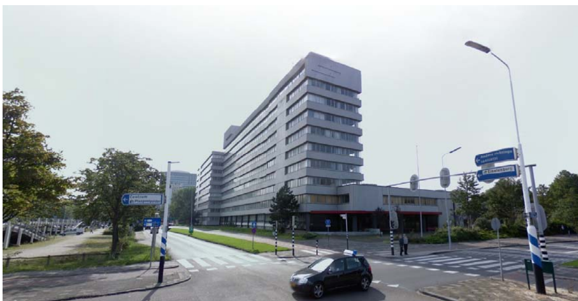
Afbeelding 2.5.: het thans leegstaande HBG-gebouw. Bron: Google Streetview
