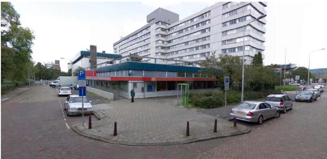
Afbeelding 2.3.: het voormalige postkantoor aan de Prinses Irenelaan. Bron: Google Streetview
