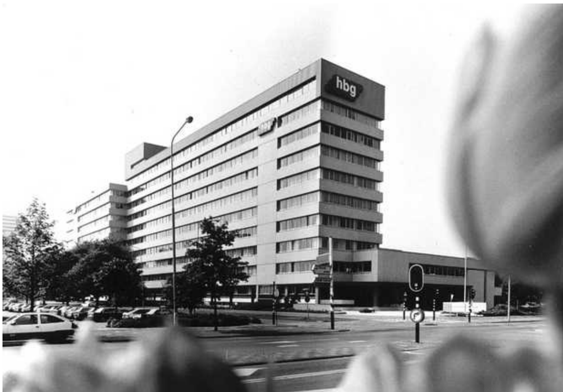
Afbeelding 2.4.: een historische foto van het kantoor van de Hollandse Beton Groep aan de Generaal Spoorlaan. Bron: ANP Historisch archief.
