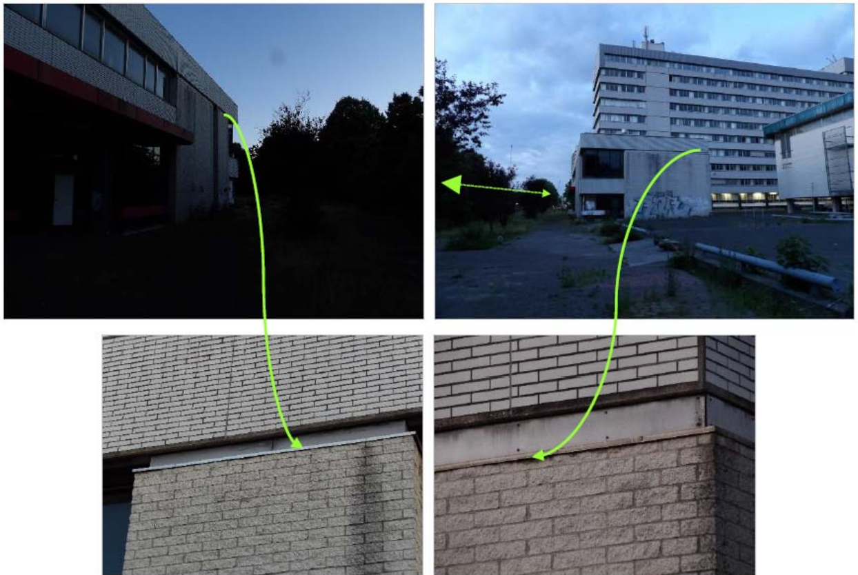
Foto's 6 t/m 9: Uitvlieglocaties van Gewone dwergvleermuis aan noordwestzijde van het Syntrus/KPN-gebouwencomplex. Op beide plaatsen betrof het één uitvliegend exemplaar. Telkens na uitvliegen eerst foeragerend langs bomenrij om vervolgens westwaarts te vliegen.
