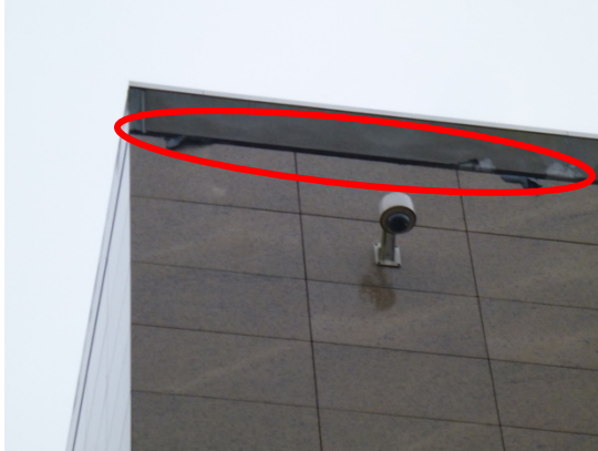
Twee verschillende locaties waar de dakrand beschadigd is en een geschikte opening voor vleermuizen biedt.
