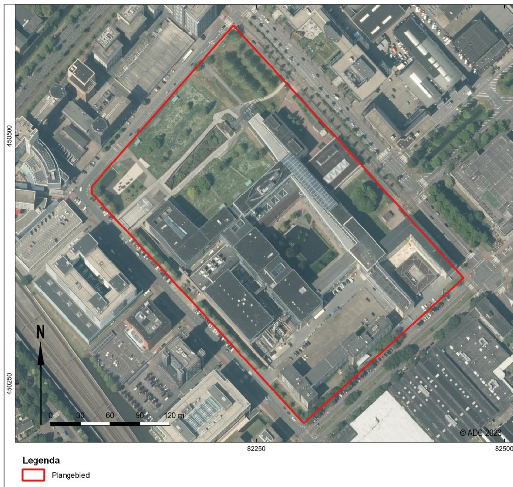
Afb. 5. Het plangebied op een recente luchtfoto (PDOK)
