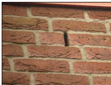
Figuur 7. Open stootvoeg westzijde buiten planlocatie (van belang voor vleermuizen).
