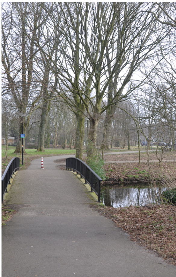
Bestaande brug voor t Juliaantje
