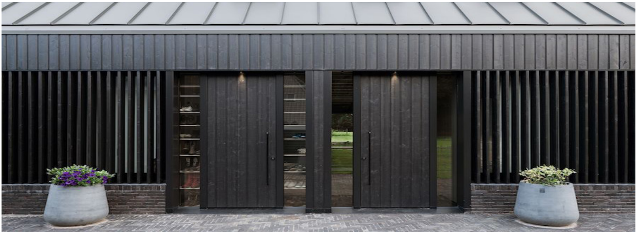
Duidelijke geleding en dieptewerking in de gevel
