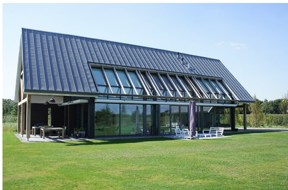
Dominante kapvorm, De grote veranda's worden meeontworpen in de vorm van het hoofdgebouw.
