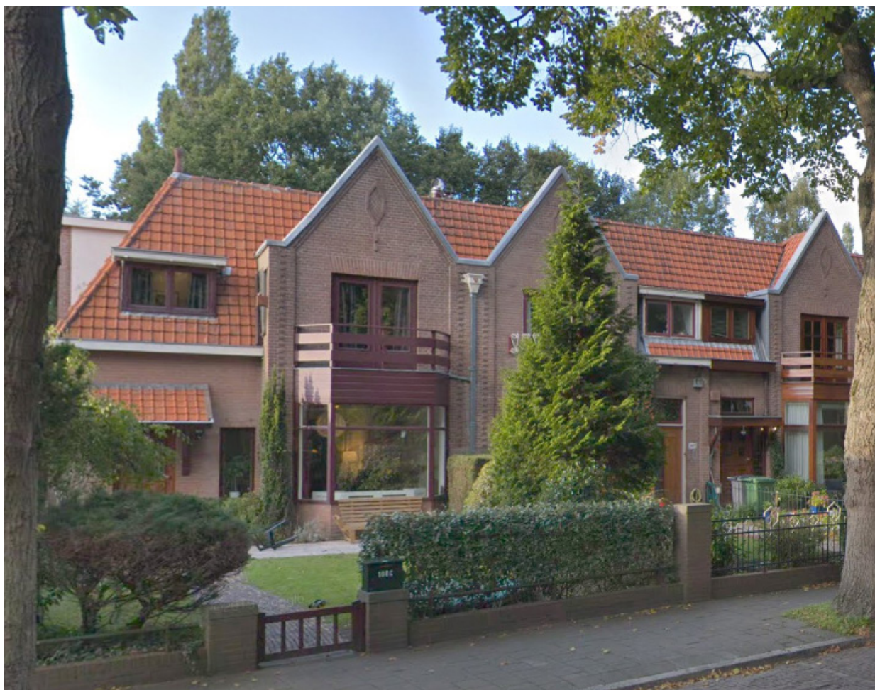
de bestaande woningen aan de Van Vredenburgweg dienen als inspiratie voor de nieuwe woningen.
