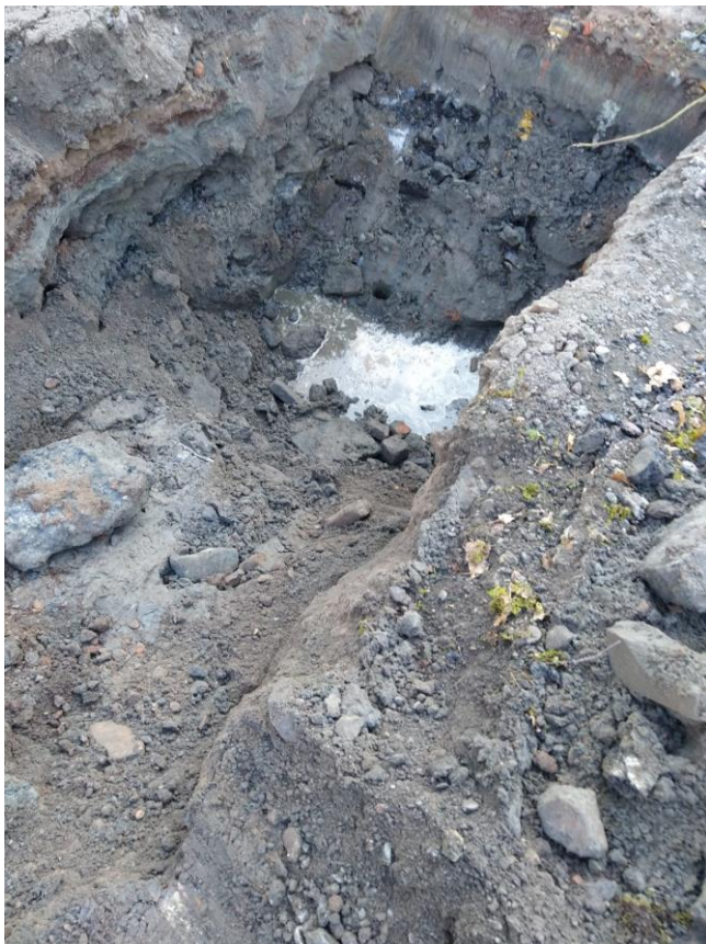
Afbeelding 5: Foto van het kijkgat bij boring 12 (puinophoging)
