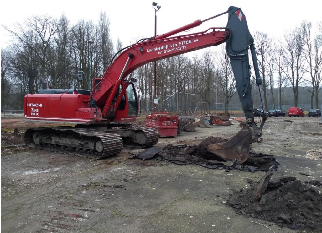
Afbeelding 4: Foto van het voorgegraven van de boorpunten met de graafmachine
