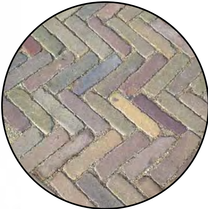
Verharding van oude (hergebruik) gebakken klinkers, 2,5 meter breed
