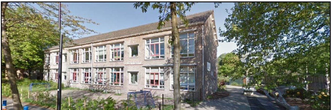
Afbeelding 5: Zicht op schoolgebouw J.H. Snijdersschool vanaf Jacob van Offwegenlaan.
