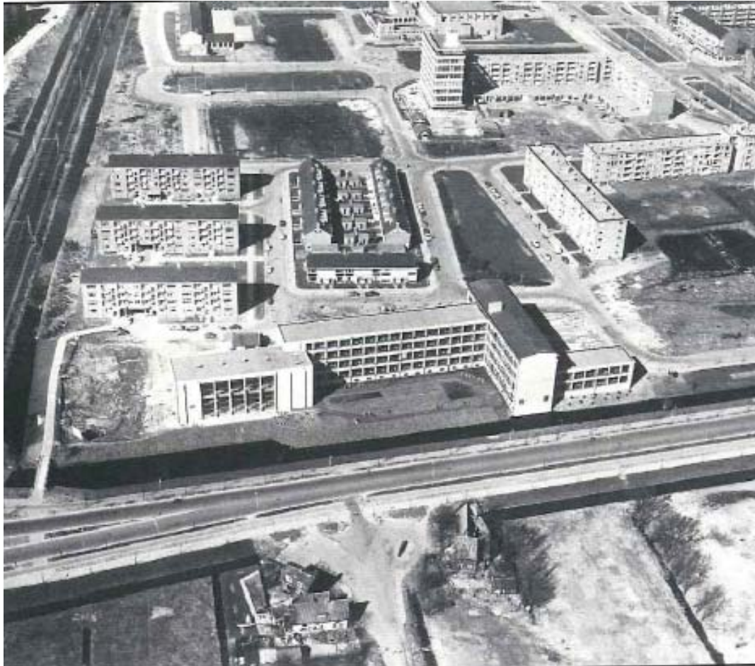
Afbeelding 2.1.: het oostelijke deel van het Stationskwartier in september 1962. Op de voorgrond de Sir Winston Churchilllaan en het Stanislascollege. Links de (toen nog bovengronds gelegen) spoorbaan. Op de achtergrond is basisschool 'De Piramide' zichtbaar.
