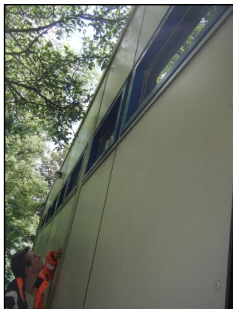
Foto 1: het noodlokaal biedt geen ruimte voor vleermuizen en vogels
