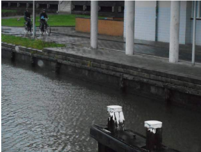
F1 oever T01-BB-OV008: meerpalen, betonnen damwand, pand direct naast damwand, trottoir en fietspad zichtbaar.
