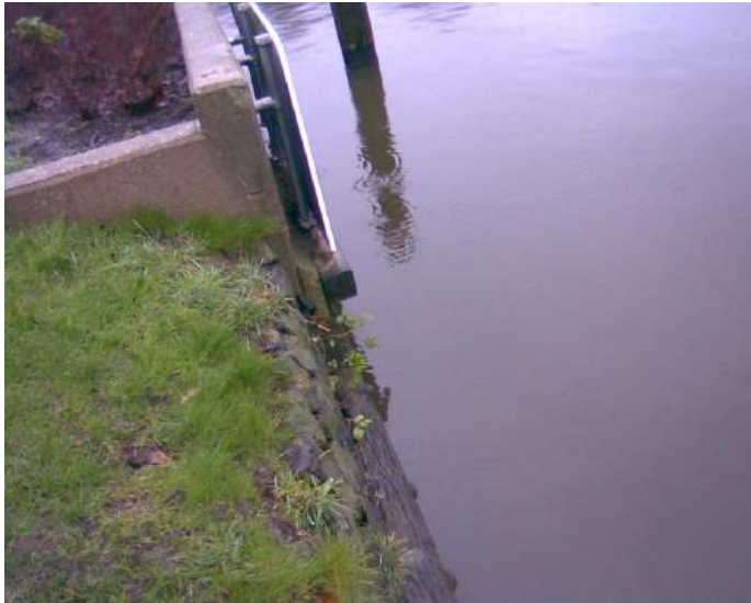
F 20-21: oever T01-BB-OV061: betonnen keermuur zichtbaar, oever T01-SB-OV074: basaltzetsteen zichtbaar.
