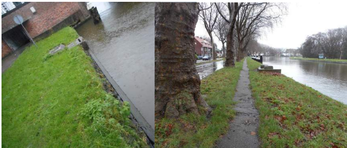
F10-11: oever T01-SB-OV131-133: grasstrook en uitstroomvoorziening, oever T01-BB-OV101-103, groenstrook uitstroomvoorzieningen en (stalen) afmeerlocaties voorzieningen zichtbaar.
