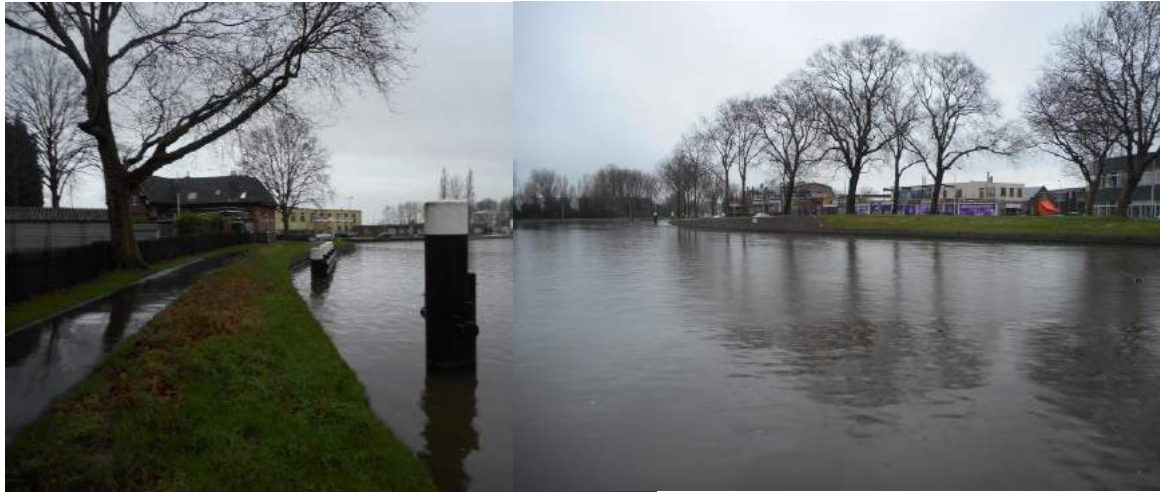
F8-9: oever T01-SB-OV126: (stalen)afmeer voorzieningen, oever T01-BB-OV098-099: keermuur van metselwerk, zinker locatie zichtbaar.
