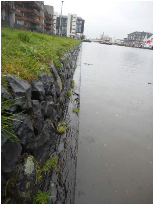
F3 oever T01-BB-OV007: basalt zetsteen zichtbaar.
