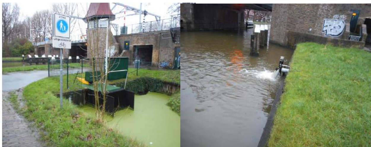
F6-7 oever T01-SB-OV126-127: Uitstroomconstructie gemeente Delft zichtbaar.
