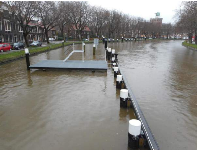
F4 oever T01-BB-OV124-125a: Naorlogs aangelegde stalen afmeerconstructie zichtbaar.
