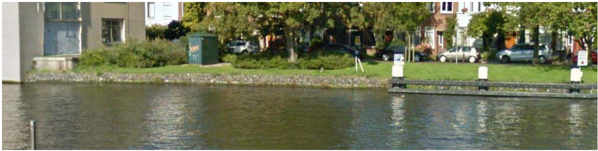
F 19: oever T01-SB-OV085 stalen afmeervoorzieningen en groenstrook zichtbaar.
