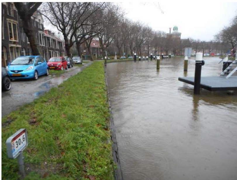
F5 oever T01-BB-OV124-125a: Naorlogs aangelegde stalen afmeerconstructie zichtbaar.
