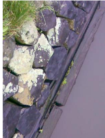
F 20-21: oever T01-BB-OV061: betonnen keermuur zichtbaar, oever T01-SB-OV074: basaltzetsteen zichtbaar.
