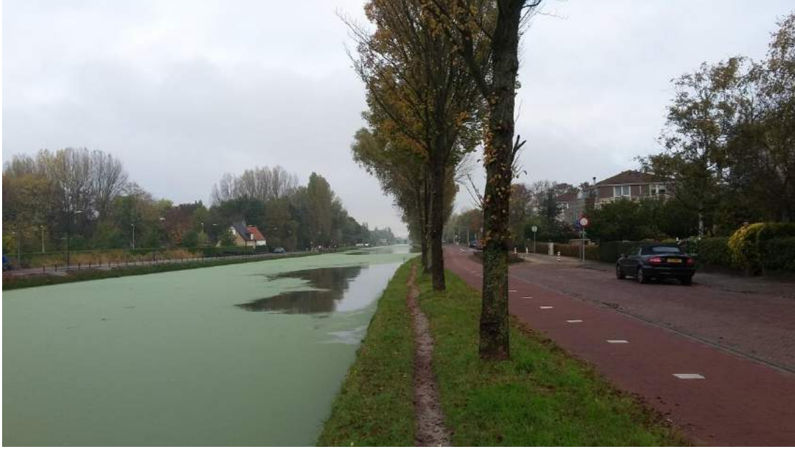
De kade aan de Delftweg met soortarme berm en een kroosdek op het kanaal
