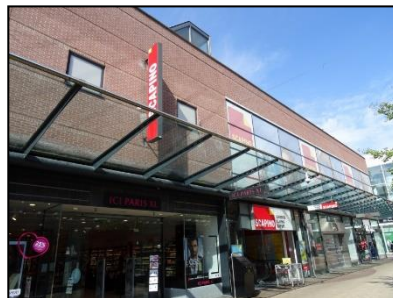
Figuur 4. Noordoostgevel van de bebouwing.
