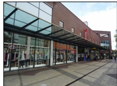
Figuur 5. Noordoostgevel van de bebouwing.
