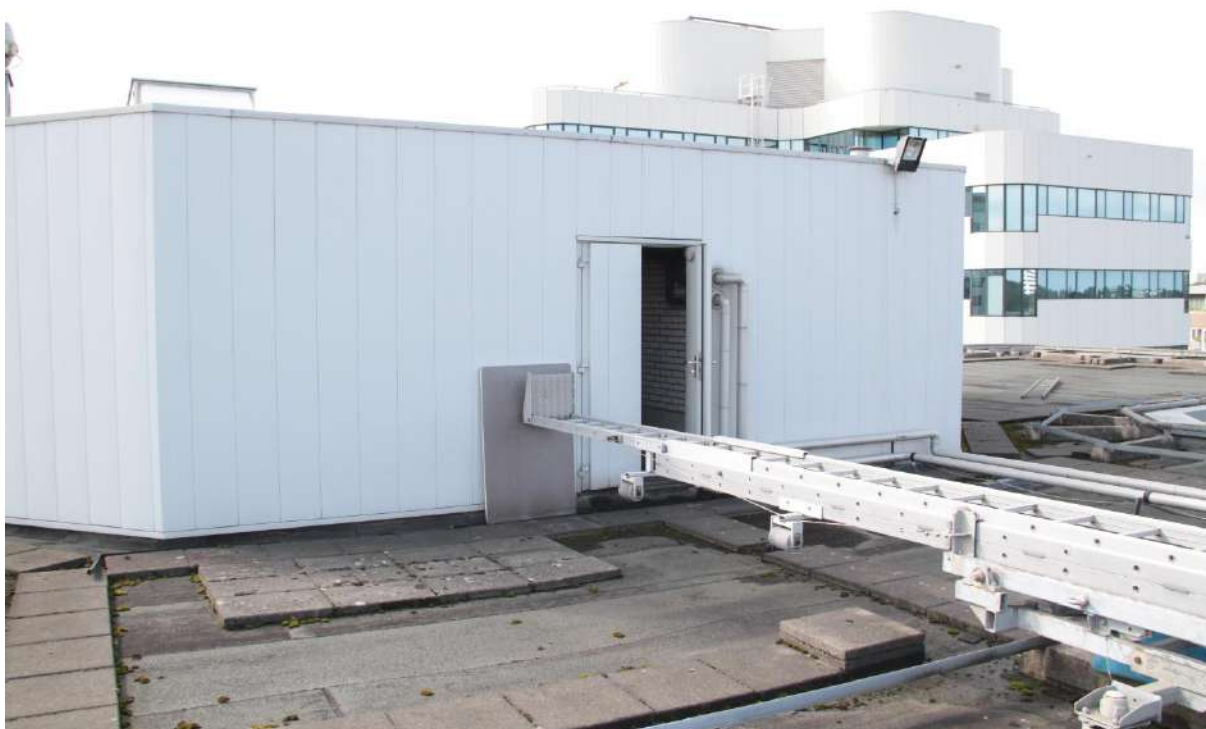
Figuur 6: Het dak van het kantoorgebouw.
