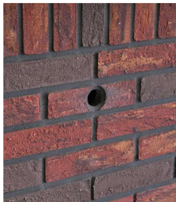
Huisumus nestkast iets verdiept verwerkt in het metselwerk en afgewerkt met steenstrips (gezaagd uit de toegepaste gevelsteen). Dit zelfde verwerkingsprincipe geldt ook voor de nestkast van de gierzwaluw.
