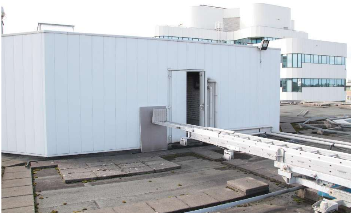
Figuur 6: Het dak van het kantoorgebouw.
