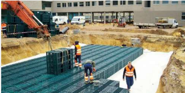
Infiltratiekratten en –putten
