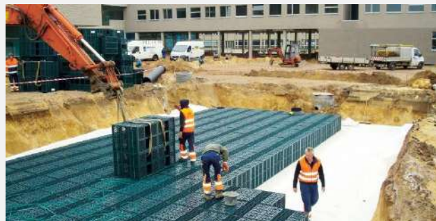
Infiltratiekratten en -putten
