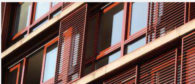
Dubbele gevel / klimaatgevel
