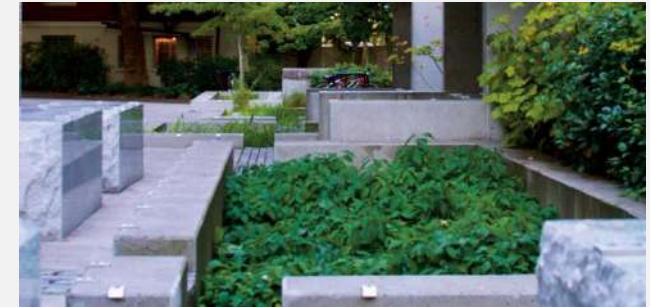
Infiltratiestroken met bovengrondse en ondergrondse opslag
