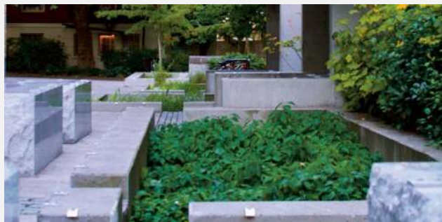
Infiltratiestroken met bovengrondse opslag
