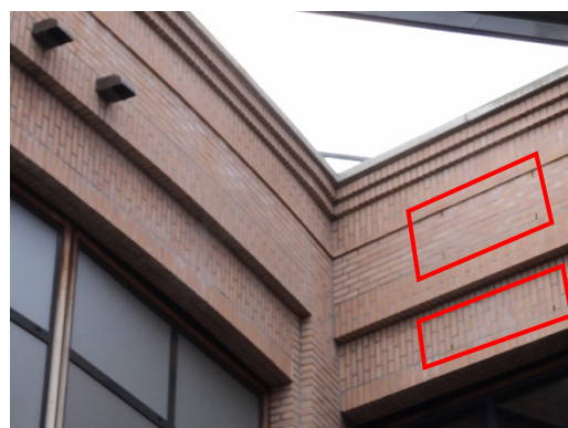
Open stootvoegen langs de oostelijke ingang van de winkelpassage.
