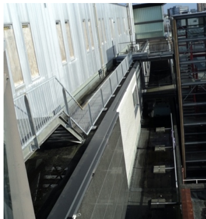
Indruk van de gevel van het V&D-gebouw met natuursteen en aluminium beplating.
