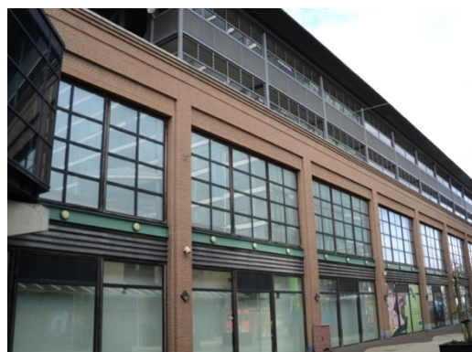
Indruk van de gevel onder de appartementen aan de oostelijke kant van het plangebied.
