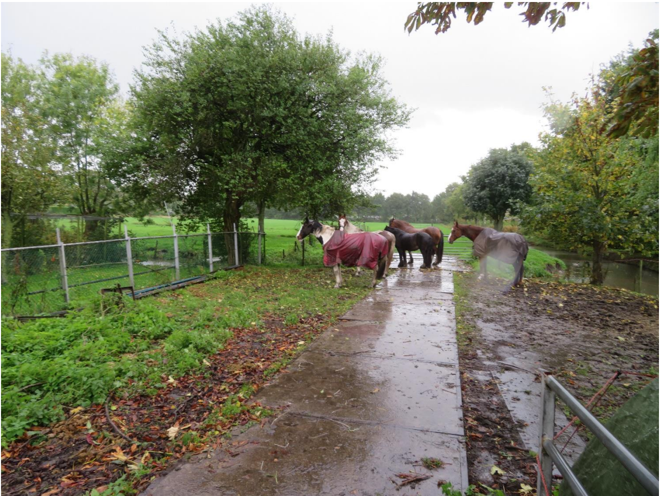
Betonplaten die toegang geven tot het grasland waar de paardenbak wordt gerealiseerd.
