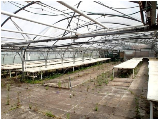
Foto 3: Binnenzijde van de kassen
