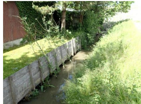
Foto 4: Watergang aan westzijde van het plangebied
