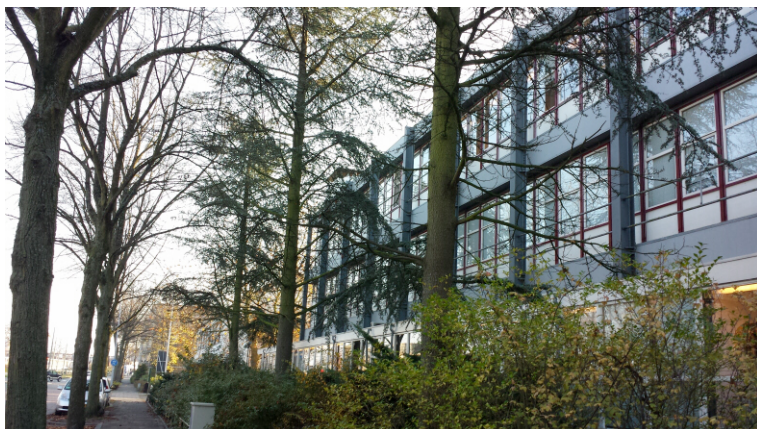
Voorzijde plangebied, gezien naar het zuidoosten.
