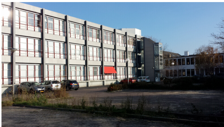
Achterzijde plangebied, gezicht op parkeerterrein en gevel. Gezien naar het zuidoosten.
