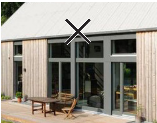
FOUT: Kozijn stopt. FOUT: Materiaal langsgevel verandert op goothoogte/knik
