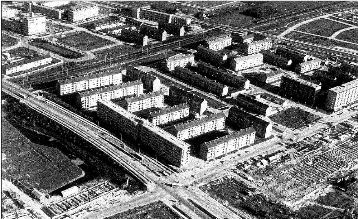
Afbeelding 2.2.: Het westelijke deel van het Stationskwartier ('Artiestenbuurt') in oktober 1963. Op de voorgrond de Generaal Spoorlaan, rechts de Steenvoordelaan en het in aanbouw zijnde winkelcentrum In de Bogaard. Op de voorgrond, aan de Generaal Spoorlaan de Jolandaflat aan de Louis Davidsstraat.
