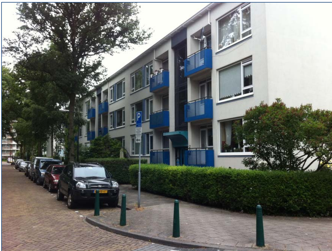
Afbeelding 2.8.: gebouw met woningen aan de Louis Bouwmeesterstraat
