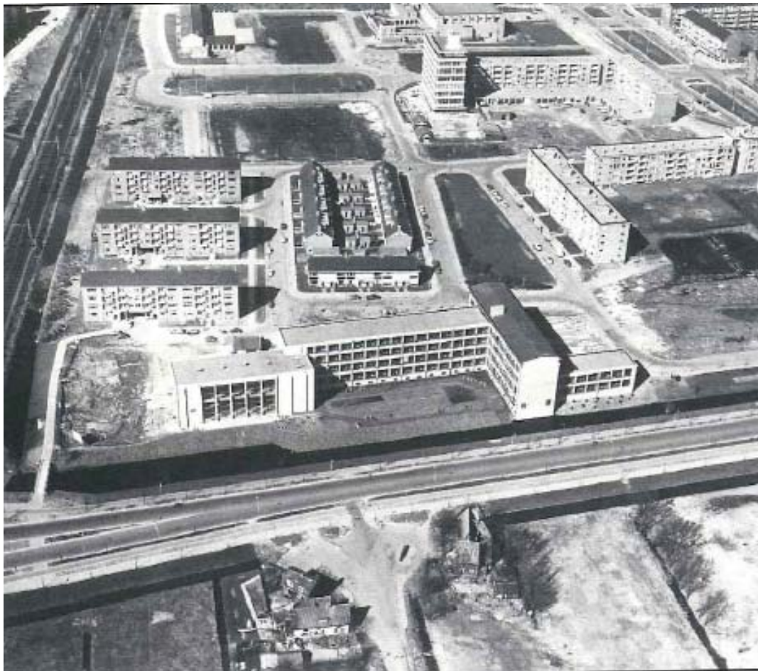
Afbeelding 2.1.: het oostelijke deel van het Stationskwartier in september 1962. Op de voorgrond de Sir Winston Churchilllaan en het Stanislascollege. Links de (toen nog bovengronds gelegen) spoorbaan.
